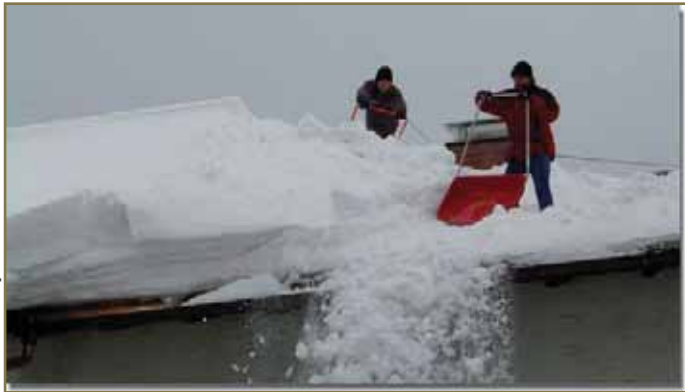
Wer sein Dach trotz großer Schneemassen nicht abschaufelt, kann im Schadensfall den Versicherungsschutz verlieren. Es würde die Sorgfaltspflicht verletzt.
